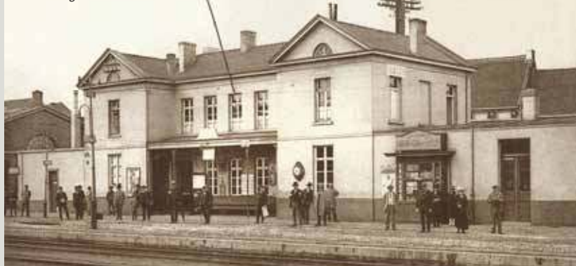
Ancienne gare de Tubize
