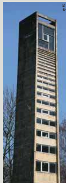
Tour d'entraînement des pompiers
