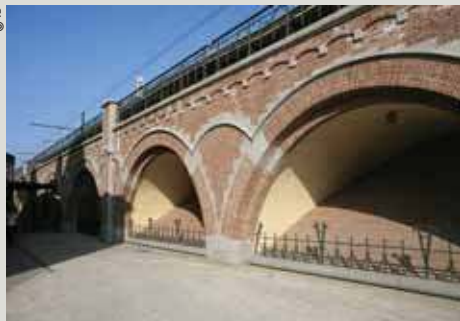
Pont du chemin de fer
