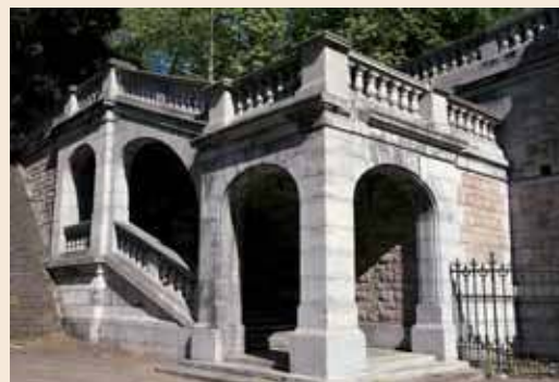
Escalier monumental du pont
