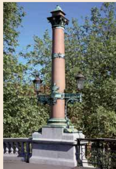
Lanternes du pont
