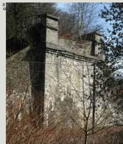
Viaduc du chemin de fer
