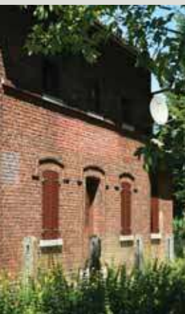
Maison du garde-barrière
