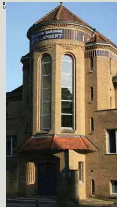
Tour centrale du sanatorium Lucie Lambert
