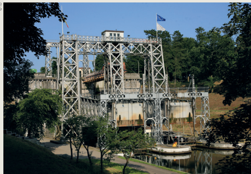
Ascenseur hydraulique n° 2 (Houdeng-Aimeries)
